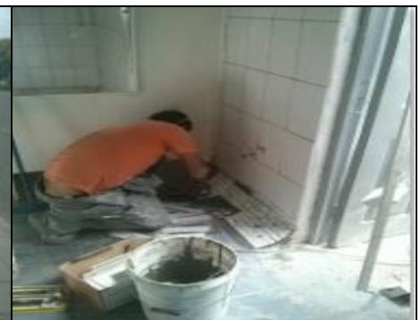
Obras de Mejoramiento
